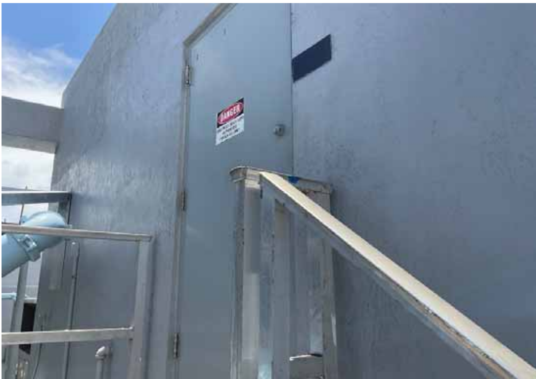
Door - Elevator Equip Room
