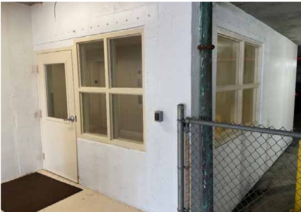
Windows & Door - Garage Elevator Lobby
