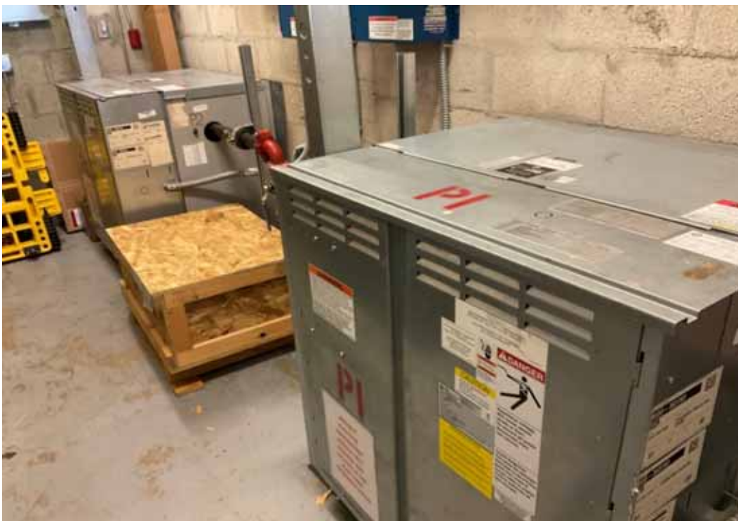
Elevator Equip - Passenger 1-2
